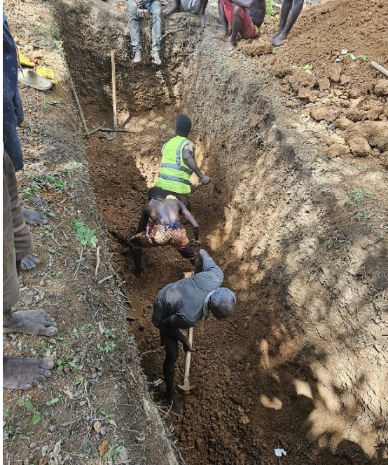
Digging the latrine pit.
